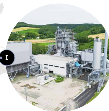
網走バイオマス発電所 2号機・3号機
