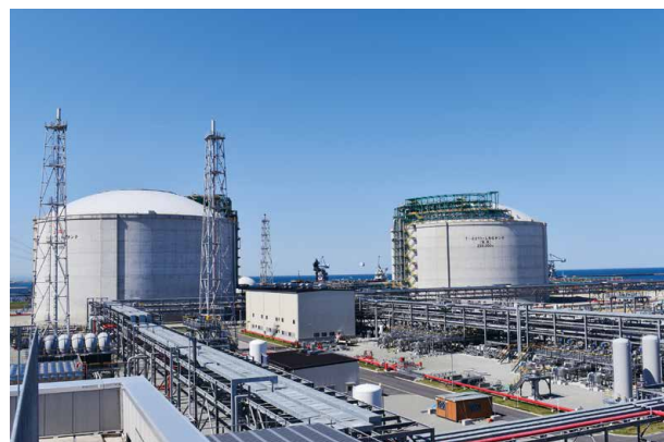
△ 相馬LNG基地
