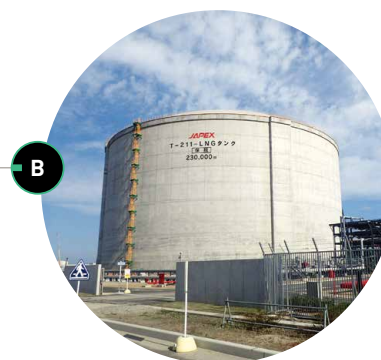
相馬LNG基地
