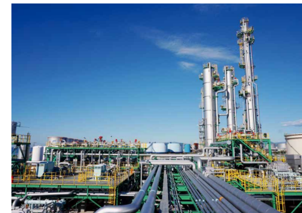
△ 苫小牧 CCS 実証プロジェクト地上設備 写真提供: 日本 CCS 調査 (株)
